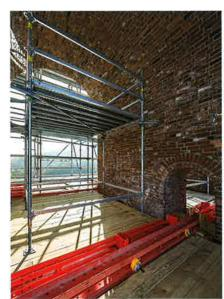
In den Hangbereichen musste das Fassadengerüst PERI UP Easy mangels Gründungsmöglichkeiten als Hängegerüst ausgeführt werden.
