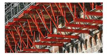
Jeweils drei 15 m lange VARIOKIT Fachwerke bilden das temporäre Tragwerk innerhalb eines Brückenbogens. Bei 32 Bögen wurden auf 173 m Länge 96 solcher Fachwerke montiert.
