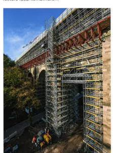
Das projektspezifisch maßgeschneiderte Tragwerk innerhalb der jeweils 3,50 m spannenden Brückengewölbe wurde mit mietbaren VARIOKIT Systembauteilen gebildet.
