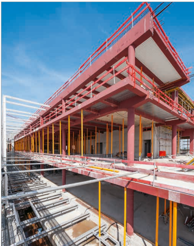
Mehr als 4.500 MULTIPROP Deckenstützen haben die Stahlkonstruktion getragen, bis diese mit ausgehärtetem Beton allein tragfähig war. Die bis zu 6,25 m ausziehbaren Stützen wogen nur 35 kg und ließen sich einfach per Hand bewegen.
