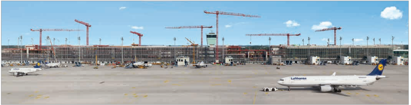
Der 600 m lange, neue Satellitenterminal am Flughafen München befindet sich inmitten des Flugfelds, es umschließt den Vorfeldtowers und gründet auf der vorhandenen Gepäcksortieranlage. Das Bauen im laufenden Betrieb war eine enorme Herausforderung für alle Projektbeteiligten.
